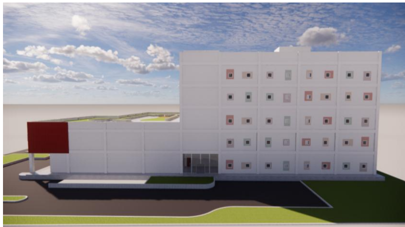
Gambar 5. Tampak barat bangunan
