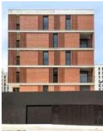
**Gambar 7. Bata merah yang di unfurnishing pada dinding exterior**
