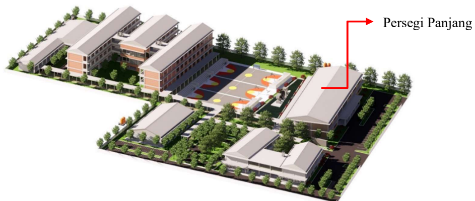
Gambar 2. Bentuk bangunan persegi panjang
