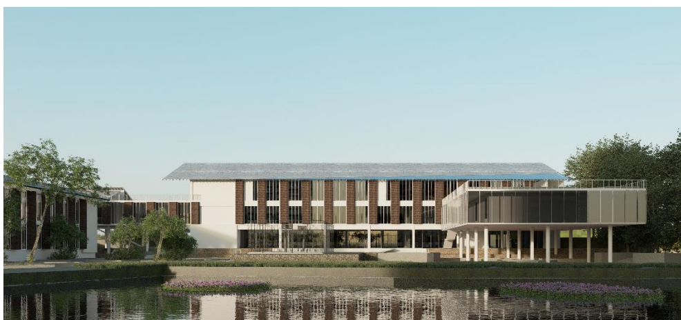
Gambar 12 Facade Bangunan Sumber : Data Pribadi
