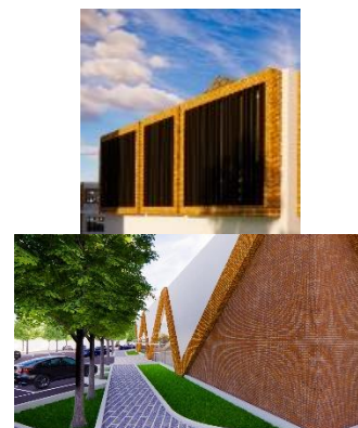
Gambar 9. Detail Fasad Bangunan Museum Sumber : Penulis, 2023
