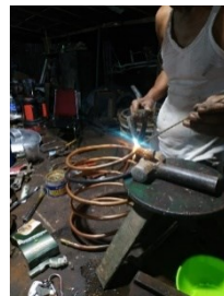
Gambar 33. Pemasangan sambungan pipa pendingin Sumber : Dokumentasi Penulis
