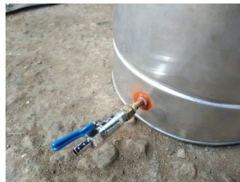
Gambar 34. pemasangan kran pada tabung kondensor Sumber : Dokumentasi Penulis
