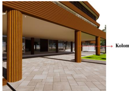
Gambar 5. Kolom yang terlihat pada fasad bangunan
