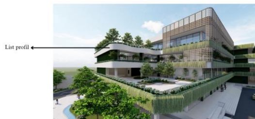
Gambar 4. List profil pada bangunan
