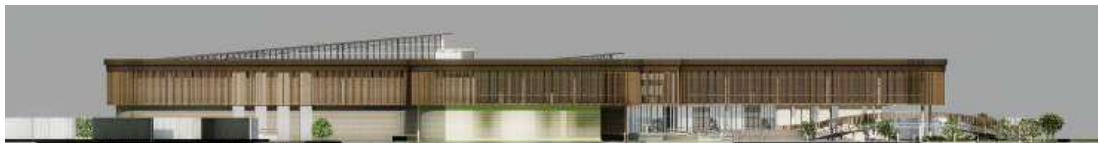
Gambar 9. Tampak Timur Bangunan Sumber: Data Pribadi, 2025
