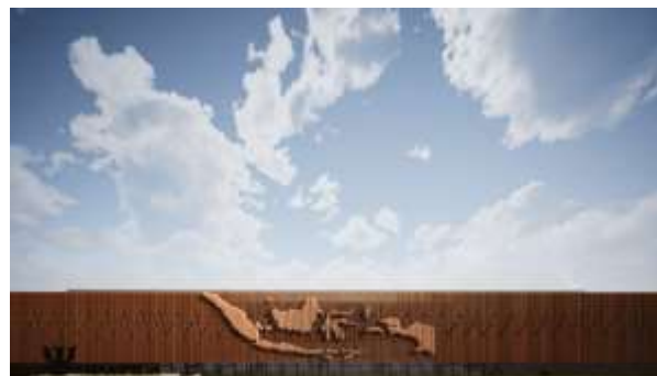
Gambar 8. Fasad Samping Bangunan
