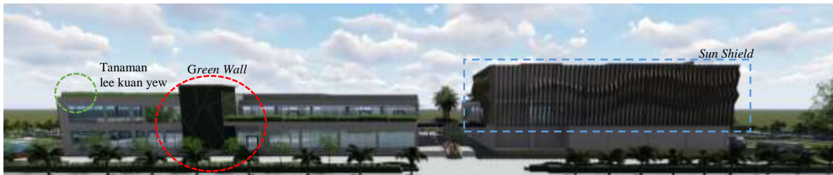
Gambar 8. Tampak Barat Bangunan
