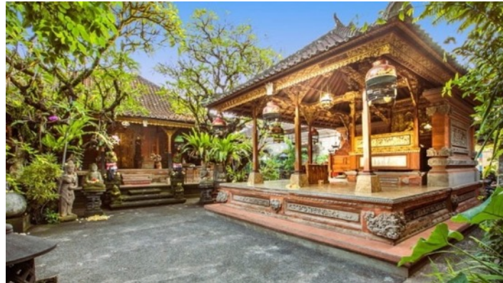
Gambar 1. Bangunan Tradisional Bali
