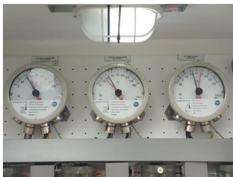
Gambar 3. Termometer Suhu Minyak, Suhu Belitan LV, dan Suhu Belitan HV
