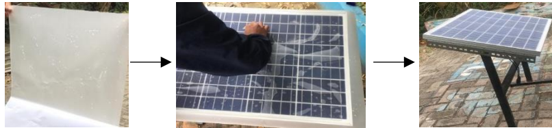
Gambar 2. Proses Pemasangan Antiglare
