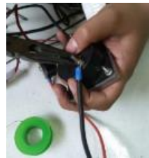
Gambar 17. Pemasangan Ampere Meter
