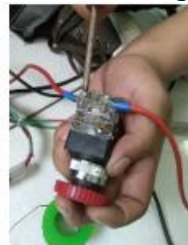
Gambar 18. Pemasangan emergency switch
