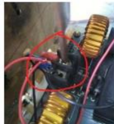
Gambar 14. Pemasangan Kabel Input
