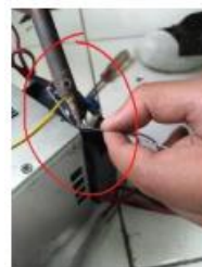
Gambar 19. Pemasangan Modul Stepdown
