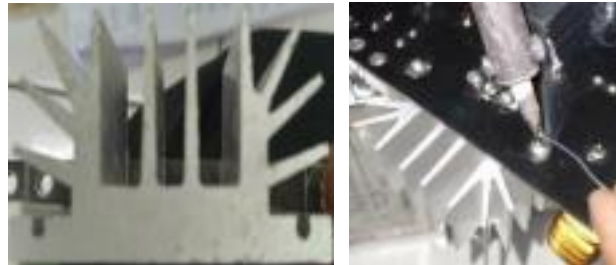
Gambar 7. Pemasangan Heatsink pada PCB
