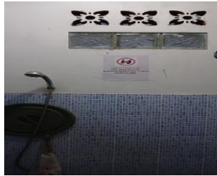
Gambar 3.10 Toilet Setelah Ditempelkan Tanda Jagalah Kebersihan Toilet
