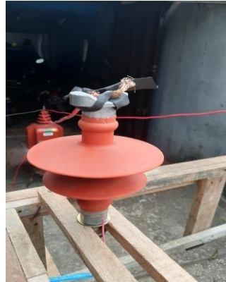
Gambar 3. Isolator Pin Silicone rubber Saat Dilakukan Pengukuran Arus Bocor
