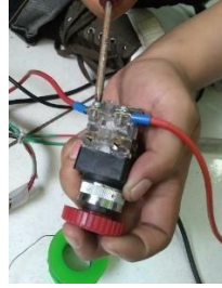
Gambar 18. Pemasangan emergency switch
