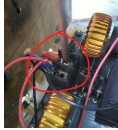
Gambar 14. Pemasangan Kabel Input
