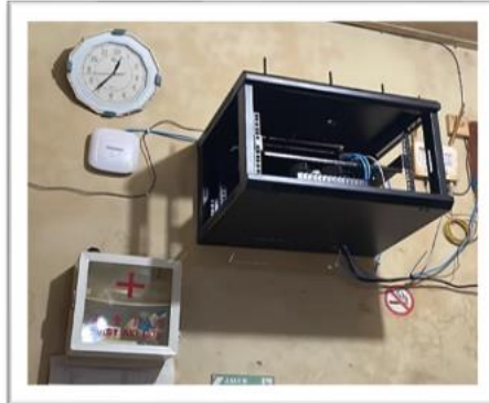
Gambar 11. Pemasangan Alat Jaringan dan Monitoring
