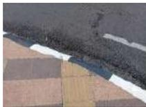
**Gambar 3.21 Pemasangan *Guiding Block* Jalur Sisi Selatan Kurang Sesuai**
