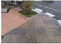
**Gambar 3.19 Pemasangan *Guiding Block* Jalur Sisi Utara Kurang Sesuai**
