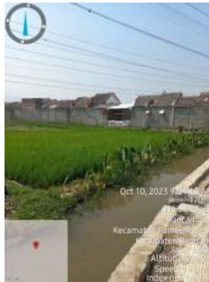
Gambar 1 Kondisi Sungai Cibayongbong (Sumber: Dokumentasi, 2023)
