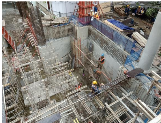
Gambar 5. Pekerjaan Pembesian Retaining Wall Pengawasan Dibantu dengan Drone
