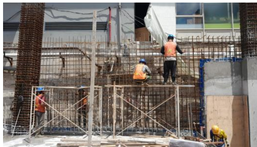
Gambar 4. Pekerjaan Pembesian Retaining Wall Pengawasan Konvensional
