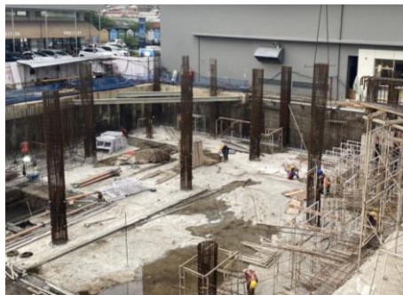
Gambar 3. Pekerjaan Pembesian Kolom Pengawasan Dibantu dengan Drone
