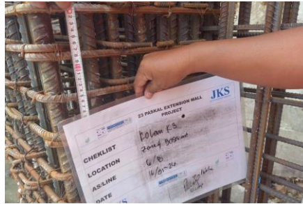
Gambar 2. Pekerjaan Pembesian Kolom Pengawasan Konvensional
