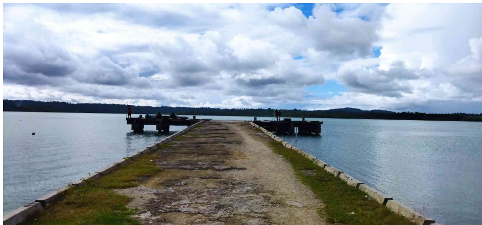
Gambar 2. Kondisi Eksisting Pelabuhan Pas Ipa
