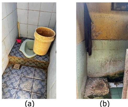
Gambar 3 Kondisi Kebersihan MCK (Sumber: Hasil Dokumentasi, 2025)
