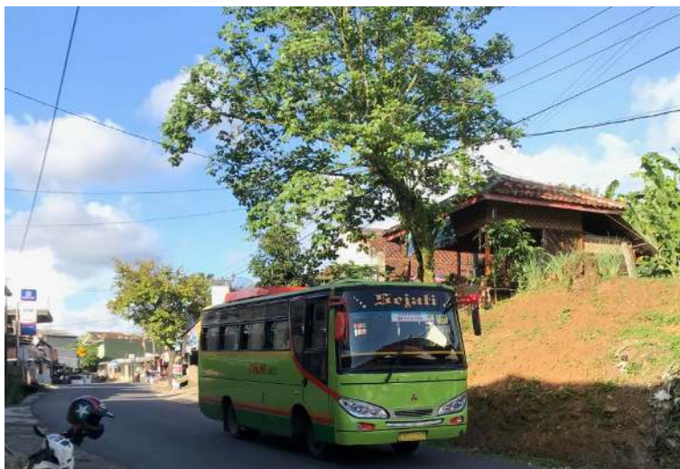
Gambar 4. Kondisi perkerasan Jalan Salopa segmen 2 (Sumber: Foto survey, 2021)
