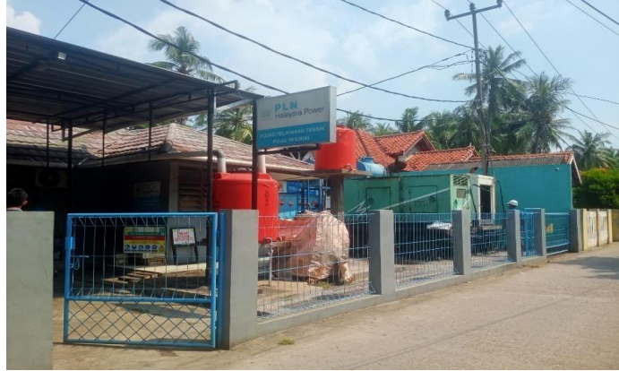
Gambar 1. PLTD Pulau Panjang, Serang Banten
