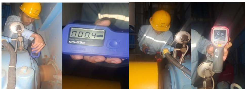
Gambar 3. Proses Pengukuran Getaran dan Suhu Blower
